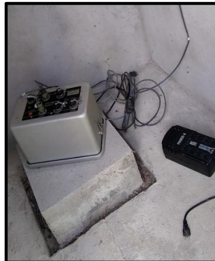
Figura 22: Mantenimiento de la caseta
